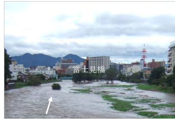
富士橋上流 (H23年9月出水)
