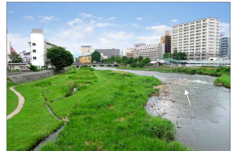
上の橋上流中州を撤去し、滞筋を平準化する
