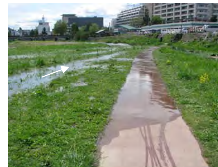
遊歩道の浸水
