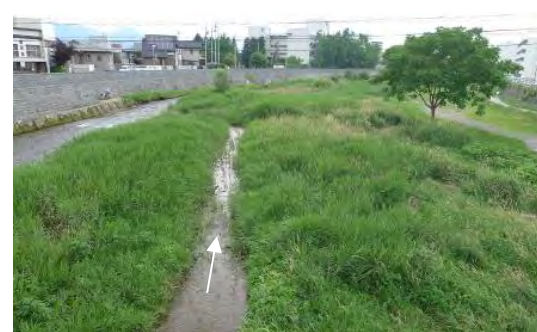
④下の橋下流
