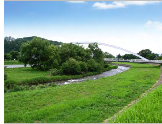
中津川橋上流
