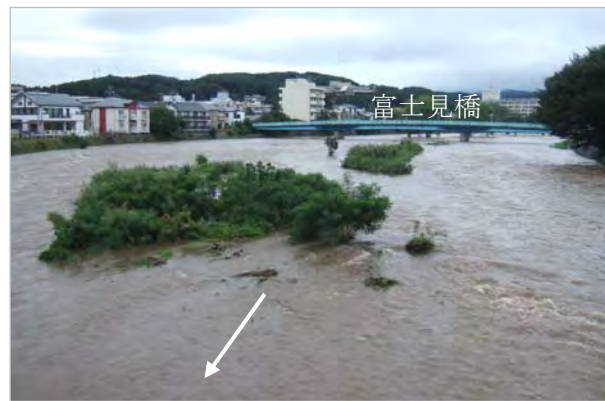
上の橋上流 (H23年9月出水)
